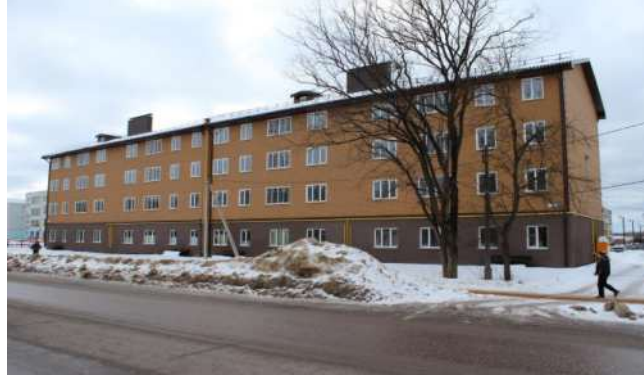
Многоквартирное деревянное домостроение
